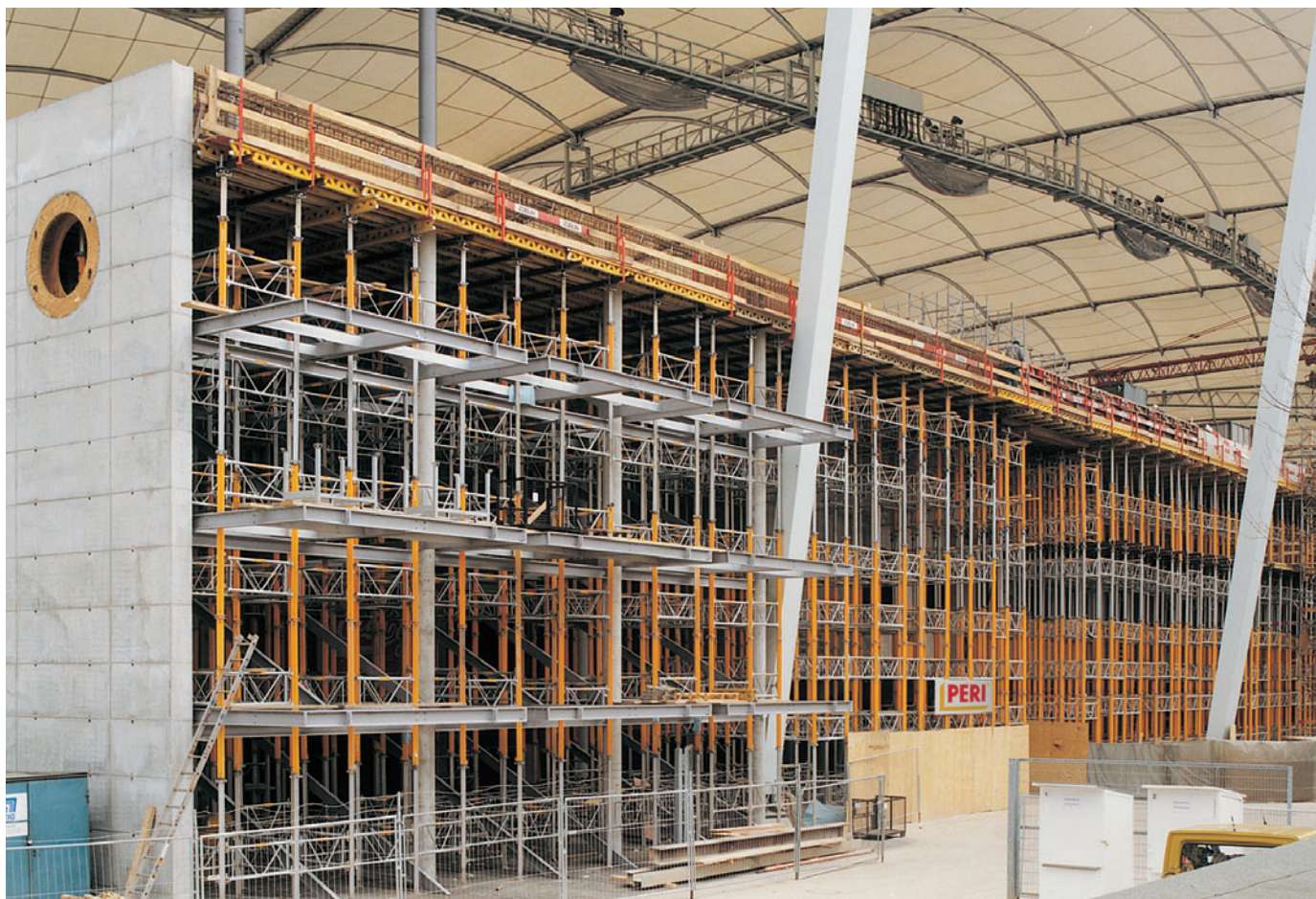
Impalcatura di sostegno MULTIPROP alta 14,00 m per una superficie di 3.500 m 2 .
