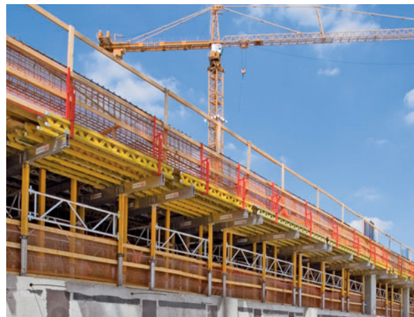
Impalcature di sostegno a torre MULTIPROP con travi in alluminio MPB come orditura primaria e GT 24 come orditura secondaria.
