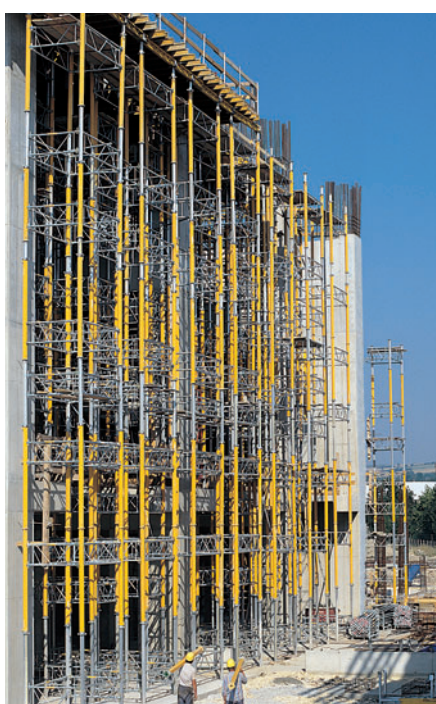
Torri MULTIPROP, alte 20 m, per la realizzazione di una soletta sporgente.
