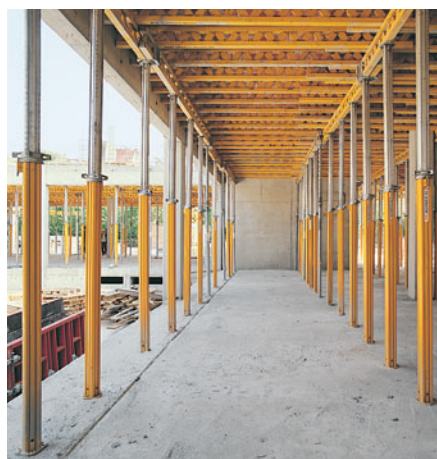
MULTIPROP 350 con la cassaforma a travi MULTIFLEX per solai.
