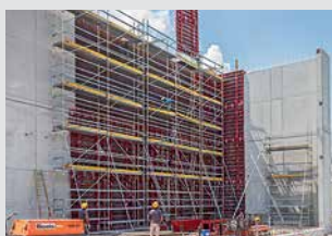
Impalcature di servizio
