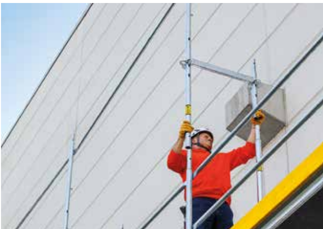
Geschlossene oder offene Fassade: Je nach Gebäude kann bei PERI UP Easy die vorlaufende Geländermontage mit dem offenen Easy-Rahmen (oben) oder mit dem Easy-Stiel (links) ausgeführt werden.
