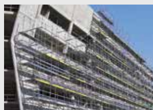
Flex Fassadengerüst, komplexe Geometrien
