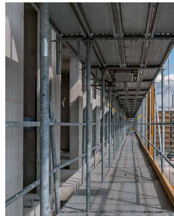
Beläge sind durch die integrierte Belagsicherung (Locking Deck) nach dem Einsetzen sofort abhebesicher.
