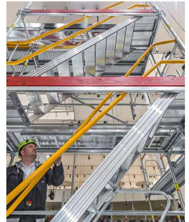
Riegel, Easy Stiele und weitere Bauteile lassen sich auch für die Erstellung einer vorgesetzten Treppe verwenden.
