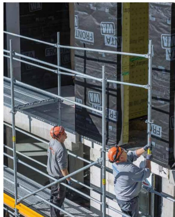
Schnelle Montage mit leichten Einzelbauteilen (z. B. Stahl- oder Alubeläge, Easy Stiele, Riegel mit Gravity Lock).
