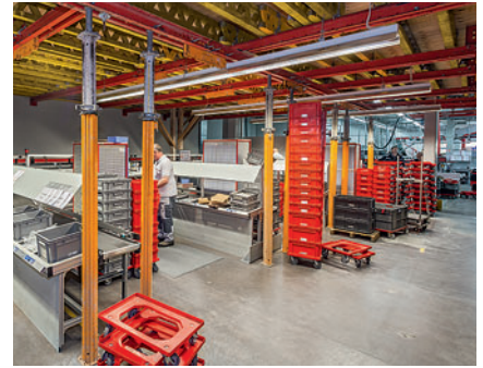
Kostengünstige Tragwerkslösung aus MULTIPROP Stützen in Kombination mit VARIOKIT Systembauteilen.
