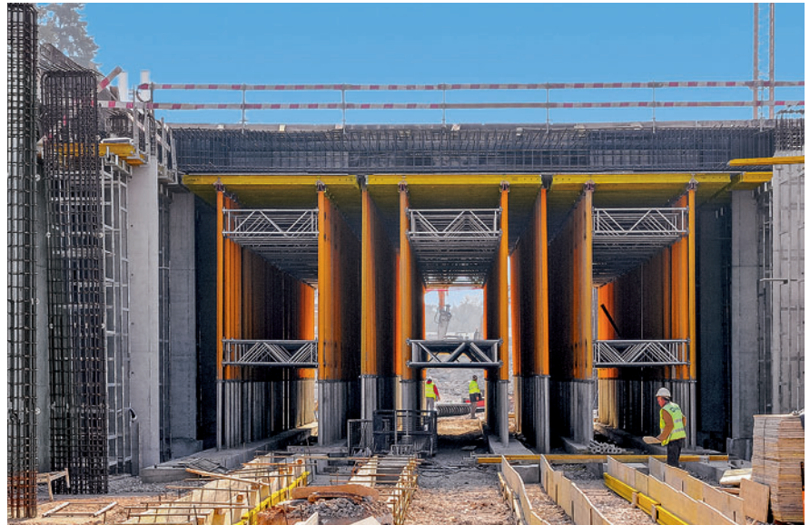
Insbesondere bei hohen Decken sind MULTIPROP Stütztürme eine wirtschaftliche Alternative zum klassischen Raumtraggerüst.
