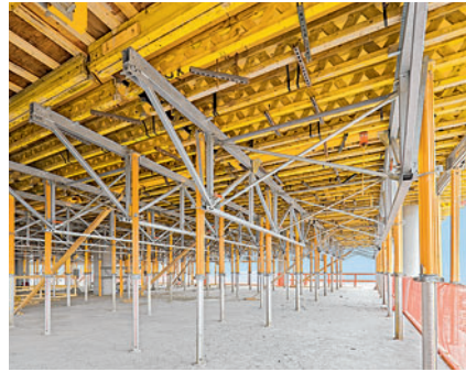
MULTIPROP Stützen, eingesetzt bei großen SKYTABLE Deckentischen, ermöglichten schnellere Zyklen bei höherem Sicherheitsniveau.
