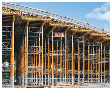
MULTIPROP Lasttürme als Unterbau für projektspezifische Deckentische.
