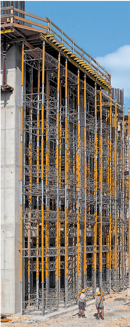
MULTIPROP Stütztürme zum Einrüsten einer 20 m hohen, auskragenden Deckenplatte.
