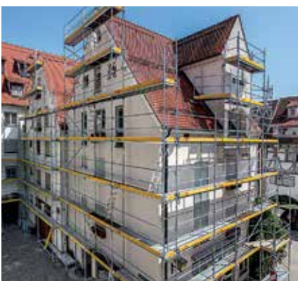
Sanierung Mehrfamilienhaus, Ulm, Deutschland
