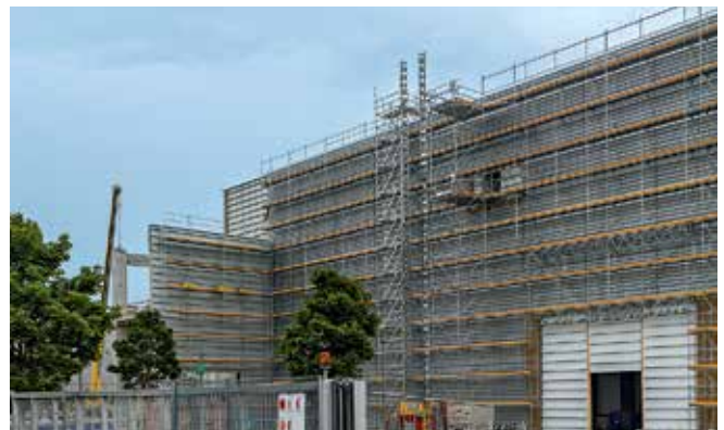
Erweiterung Halbleitertechnik-Werk Firma Zeiss, Oberkochen, Deutschland
