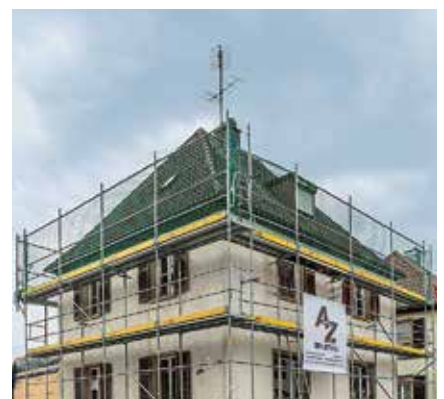
Hausrenovierung, Landau, Deutschland
