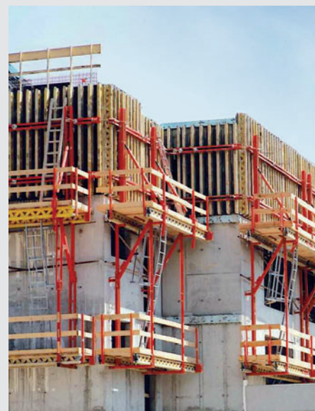
Sicherheit PERI Leiternaufstiege für den sicheren Zugang zur Nachlaufbühne.
