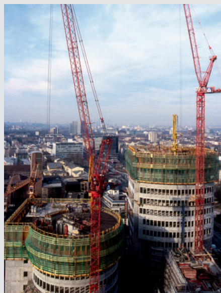
Verwaltungsgebäude CB 240 mit TRIO und VARIO GT 24.
