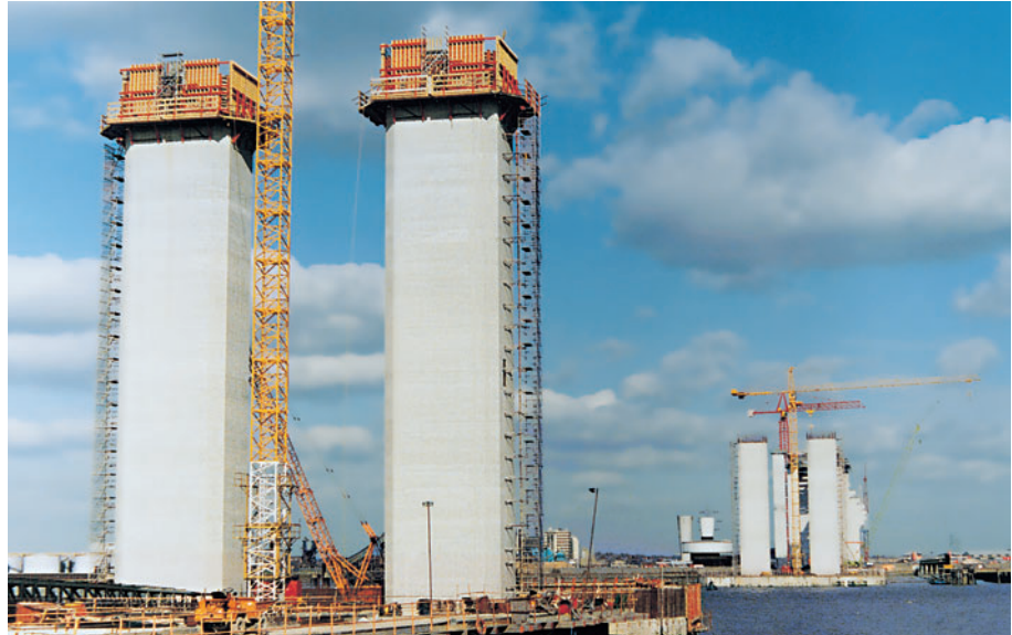
CB 240 mit VARIO GT 24 beim Bau von Brückenpfeilern.
