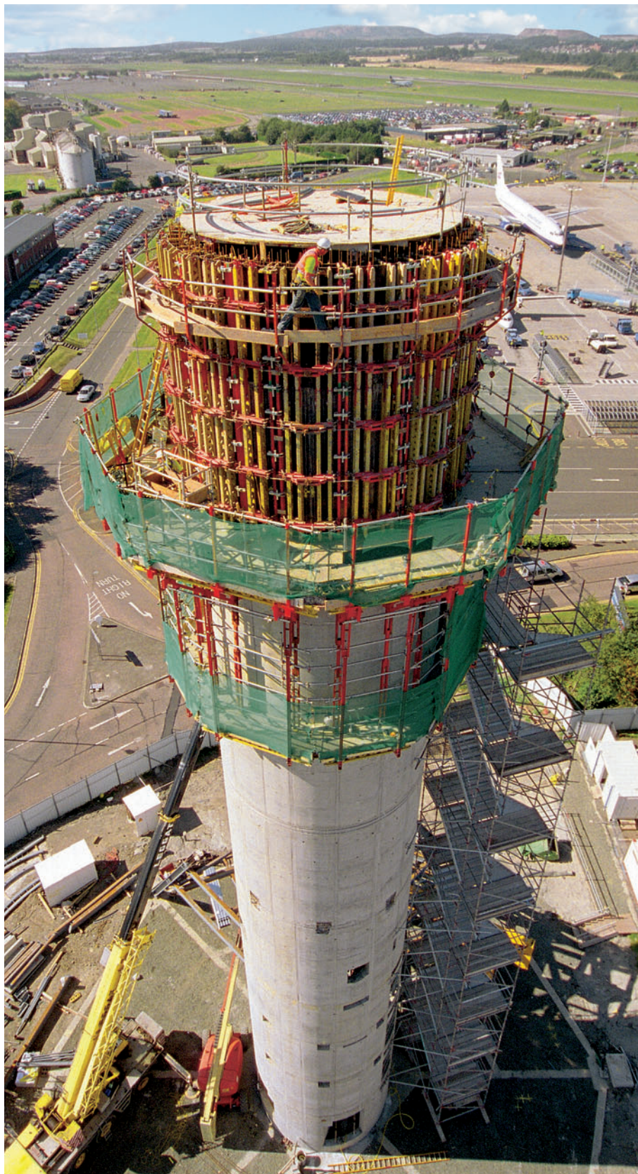
Flughafen Kontrollturm 46 m hoch, Ø 6,85 m außen. Mit PERI RUNDFLEX und CB 240 Konsolen.
