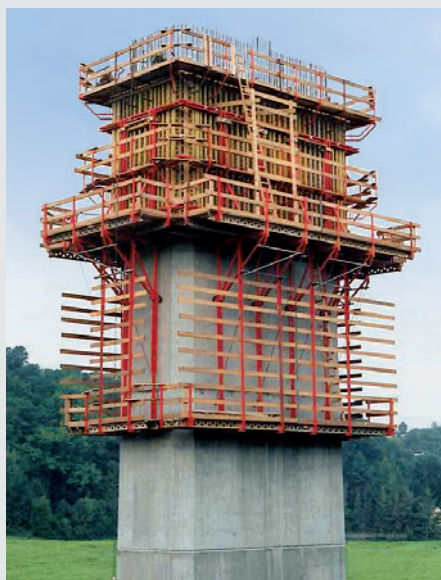
Brückenpfeiler Sichtbeton mit CB 240 und VARIO GT 24.
