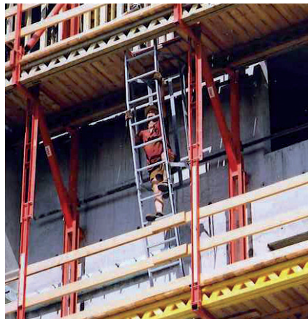
Bequemer Zugang zur Nachlaufbühne mit dem PERI Leiteraufstieg.
