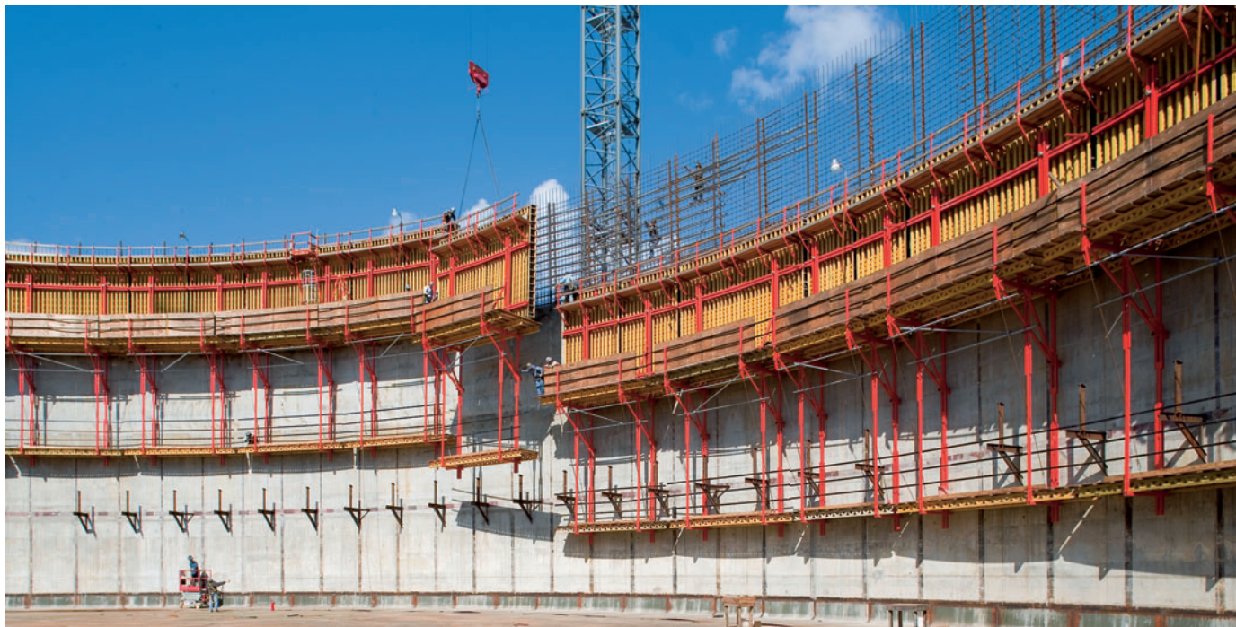
LNG Flüssiggastanks Runde Wände Ø 77,50 m mit CB 240 und VARIO GT 24.
