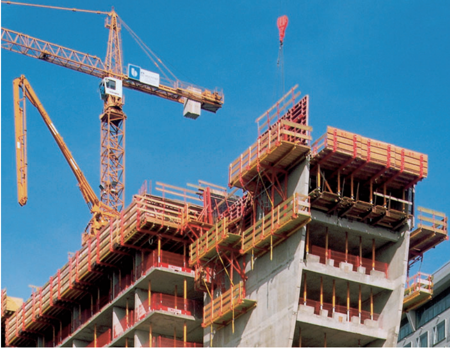
Hotelbau CB 240 Konsolen komplett mit Nachlaufbühne und TRIO.
