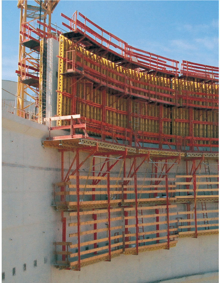
Auch der Zugang zu zwei Nachlaufbühnen wird mit Systemteilen CB 240, CB 160 gelöst.
