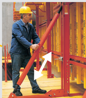
Präzise Neigungseinstellung Mit Richtspindel CB 164-224.
