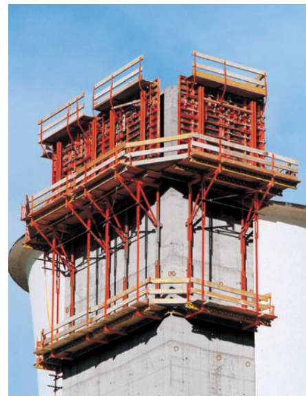
Verwaltungsgebäude CB 240 mit Nachlauf- bühnen und TRIO.
