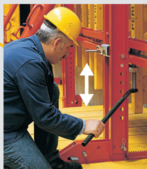
Element Höheneinstellung Bei VARIO GT 24 Mit Stelleinheit CB
