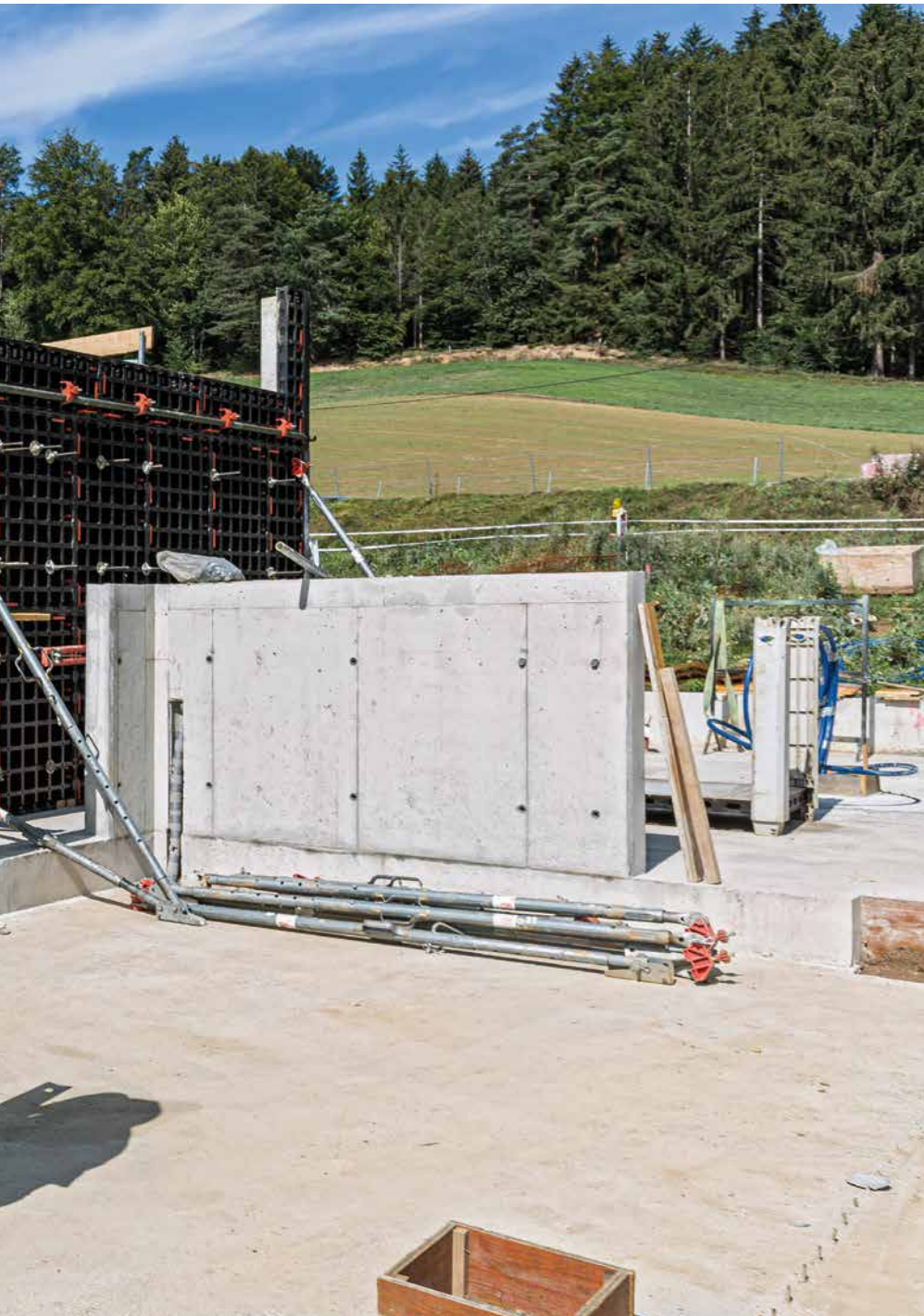
DUO Verbundschalung. Mit insgesamt 400 m 2 Schalungsvorhaltung ließen sich alle Betonbauteile ohne Kraneinsatz effizient schalen und betonieren.
