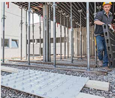
3. Bereitlegen der neuen Schalhaut
