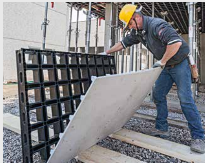
2. Entfernen der beschädigten Schalhaut
