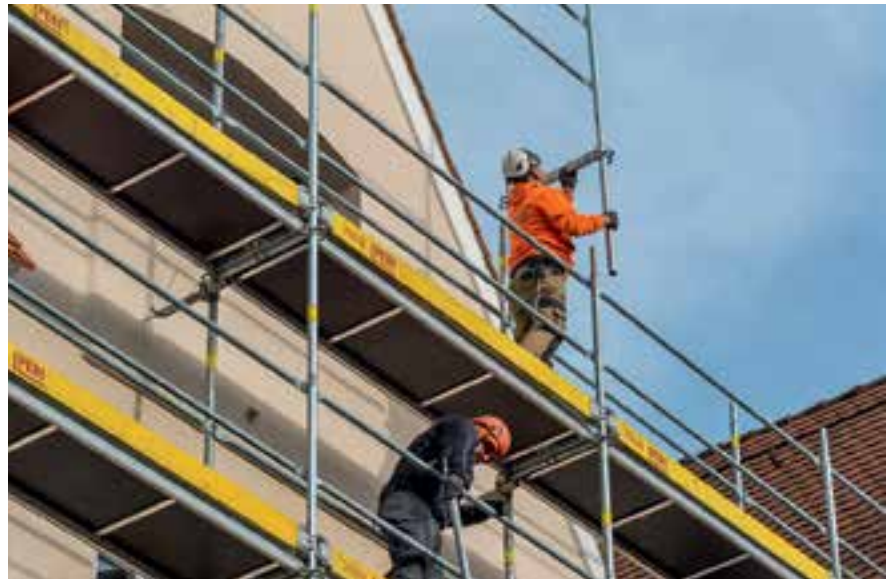
Absturzsicherung ohne Zusatzaufteile durch die systembedingte Aufbauweise im Schutz des vorlaufend montierten Geländers.
