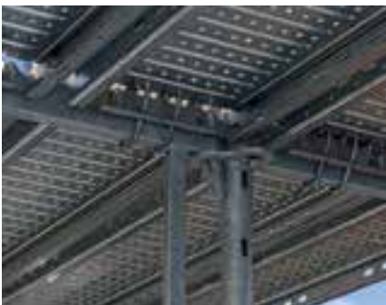
Die Abhebesicherung ist im Belag integriert: Die Bügel untergreifen den Horizontalriegel und sichern den Belag.
