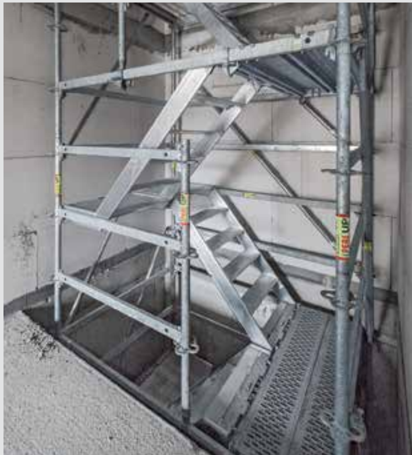
Kurze Treppenläufe mit 75 cm Breite bieten maximale Anpassungsfähigkeit für kleine Räume und enge Geometrien.
