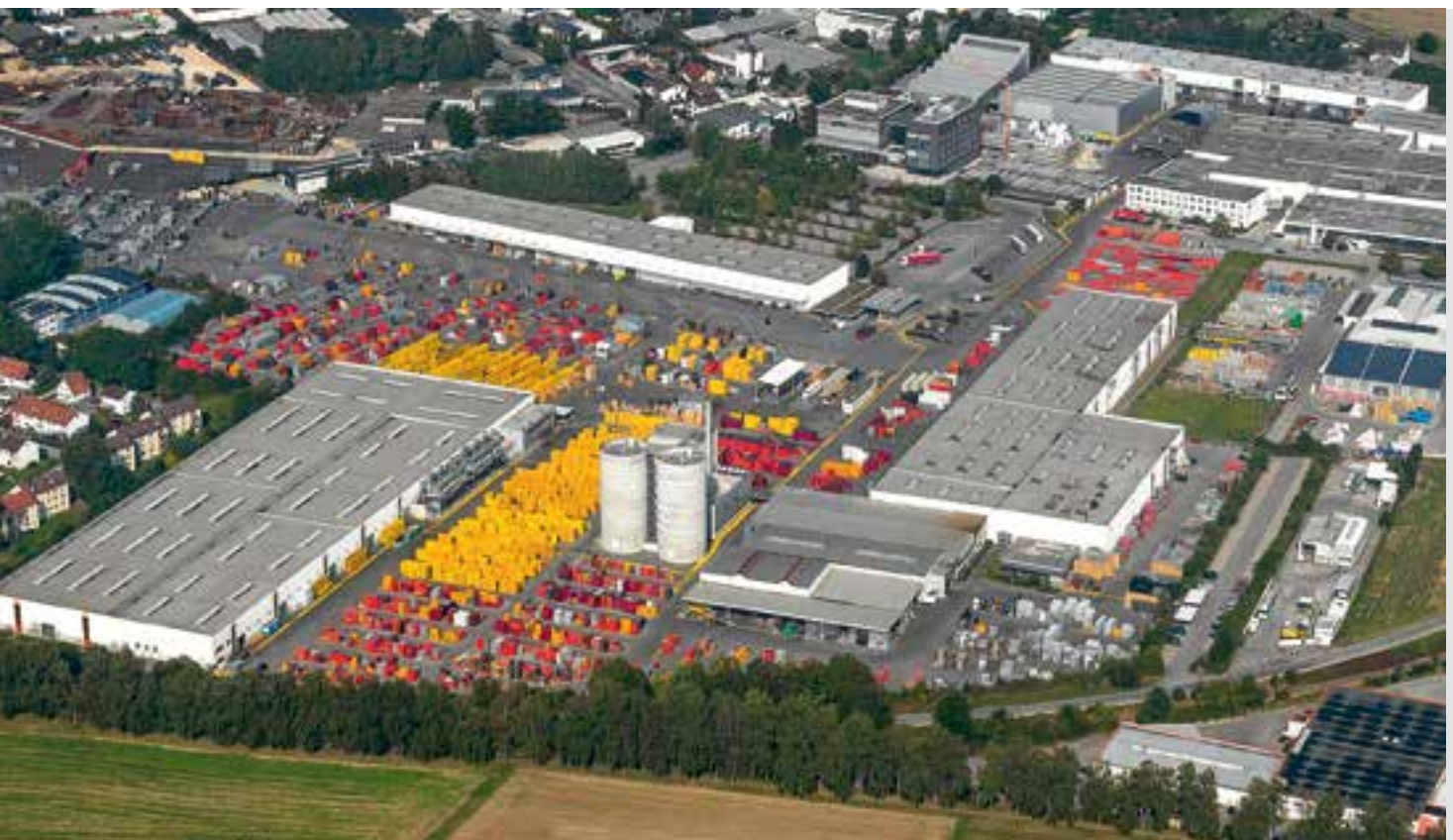
PERI in Weißenhorn: Firmenzentrale, Entwicklung und Produktion.
