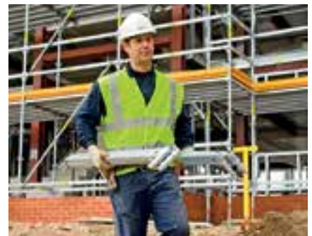
Die geringe Breite des UH Riegels ermöglicht den Transport von bis zu 4 Riegeln durch einen Monteur.
