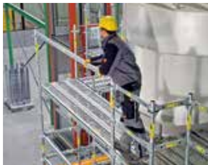
Der Gravity Lock erlaubt die einfache Montage aus sicherer Position, der Keil fällt allein durch sein Eigengewicht in die Rosettenöffnung.
