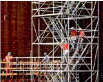
Doppelläufige Gerüsttreppen am Neubau eines Flüssiggasbehälters. Geländer an den äußeren und mittleren Wangen sorgen für sichere Laufwege.
