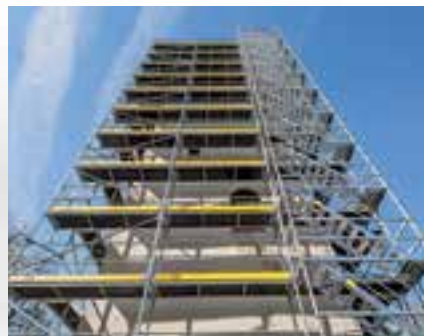
An der Rosette des Easy Rahmens lassen sich z.B. auch Treppen direkt anschließen – ohne weitere Rahmen oder Zusatzbauteile.
