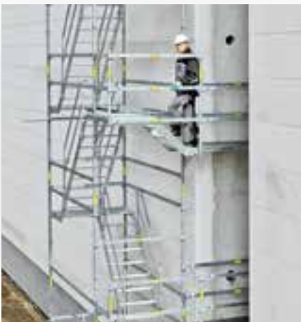
Die Anpassung an die Gebäudeöffnungen erfolgt mit kurzen Treppenläufen auf außen angehängten Konsolen – unabhängig von der Etagenhöhe.
