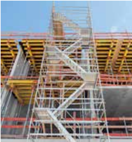
Mit der Treppe 75 lassen sich alle Arbeitsebenen auf Baustellen schnell und sicher erreichen.
