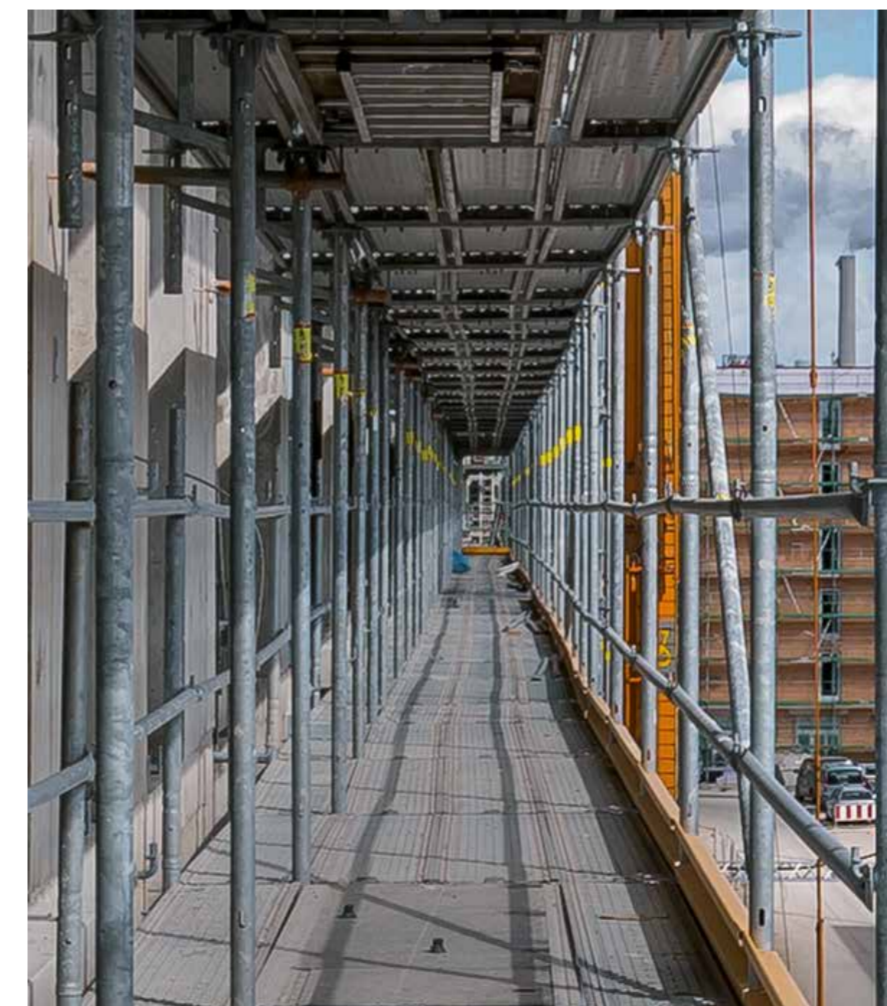
Beläge sind durch die integrierte Belagsicherung (Locking Deck) nach dem Einsetzen sofort abhebe-gesichert.
