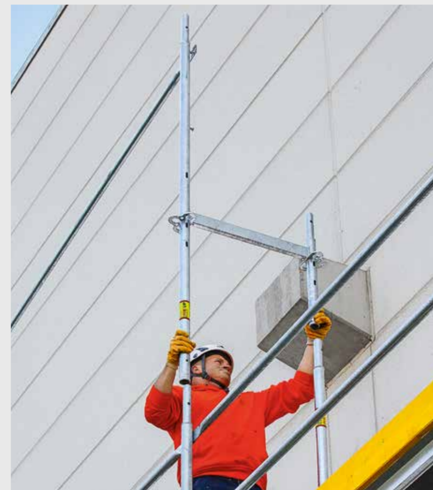
Schnellere Montage mit leichten Einzelbauteilen (z. B. Konsolen und Rahmenbauteilen). Nahezu ohne Kupplungen und mit geringem Werkzeugeinsatz zu montieren.
