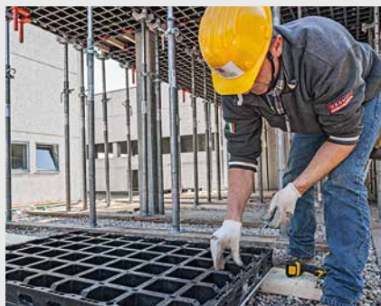
4. Festschrauben der neuen Schalhaut
