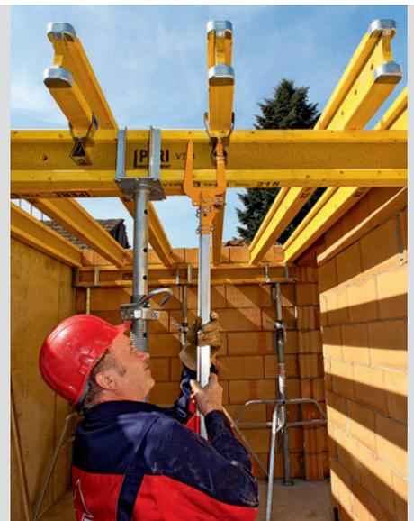
Mit dem gleichen Setzwerkzeug werden auch die Flexclips sicher vom Boden aus montiert.
