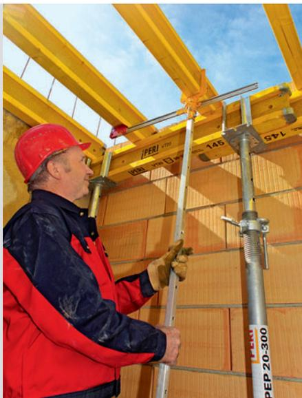
Schnelles und sicheres Auslegen und Ausrichten der Jochträger mit dem Setzwerkzeug.
