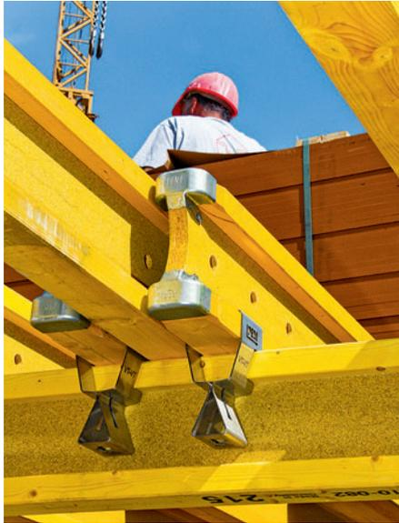
Der PERI Flexclip sichert die Querträger gegen kippen und ist in 3 Varianten, je nach Trägerkombination, verfügbar.
