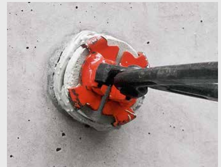
Den Betonkonus in den Abdruck stecken und mehrmals leicht drehen, damit sich der Dichtungskleber gleichmäßig verteilt.
