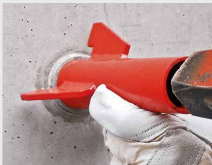
Den Betonkonus mit der Richtlehre plan klopfen.
