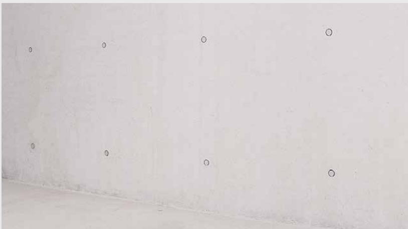
Eingeklebte Betonkonen mit Schattenfuge.
