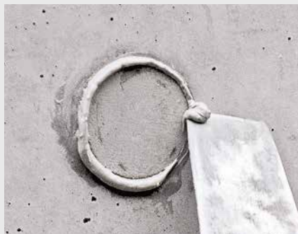
Den überschüssigen Dichtungskleber mit der Spachtel abstreifen.
