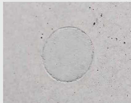
Eine saubere und dichte Ankerstelle mit dem PERI Ankersystem.
