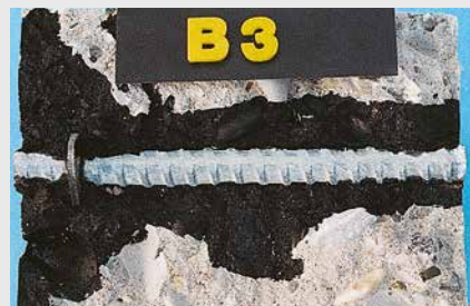
... sowie bei einbetonierten Ankerstäben.
