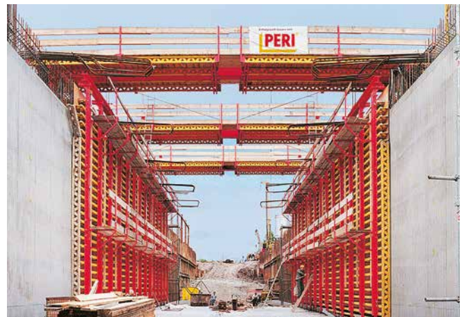
Tunnel Ortsumfahrung B 311, Ertingen, Deutschland.
