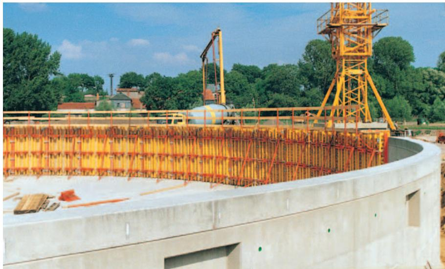
Le système PERI GRV permet d'obtenir des ouvrages circulaires sans aucun ancrage.
