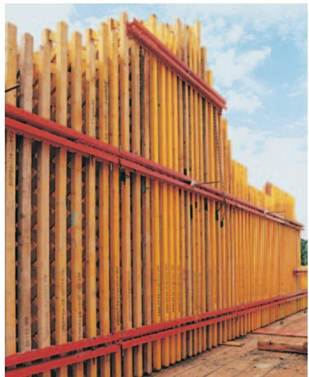
Le pas de 30 cm de la poutrelle GT 24 permet de l'adapter facilement à la hauteur requise. Ci-dessus un voile pignon destiné à la construction d'un logement.
