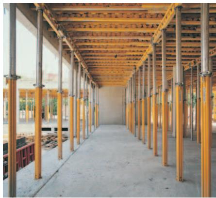
Un écartement de 2,80 m entre poutrelles primaires et de 90 cm entre étais permet d'utiliser les poutrelles GT 24 pour des épaisseurs de dalle allant jusqu'à 35 cm.
