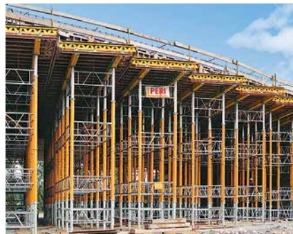
Tours d'étaie MULTIPROP comme soubassement pour tables de coffrage spécifiques.
