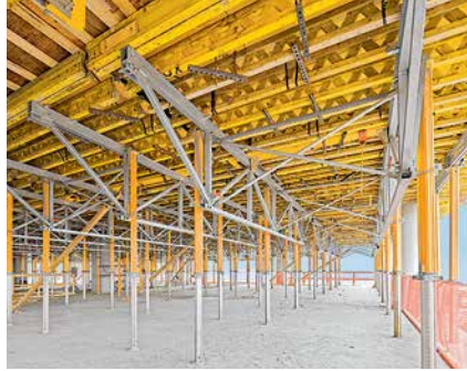
Utilisés pour de grandes tables de coffrage SKYTABLE, les étais MULTIPROP ont permis des cycles plus rapides avec un niveau de sécurité plus élevé.
