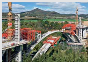
Coffrages de ponts
