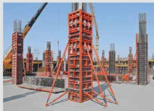
Coffrages de poteaux
