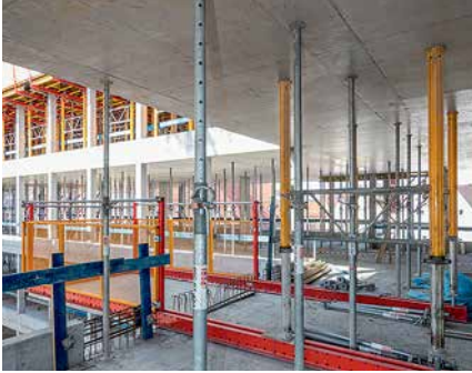
Les rails RCS de la plateforme d'extension RCS MP sont insérés entre deux dalles d'étages, à l'aide d'étais MULTIPROP.
