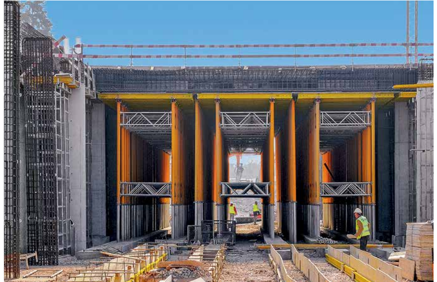
En présence de dalles hautes surtout, les tours d'étaie MULTIPROP sont une alternative économique aux échafaudages classiques.
