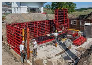
Coffrages de voiles
