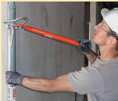
Travail ergonomique grâce à une clé de décentrement coudée.
