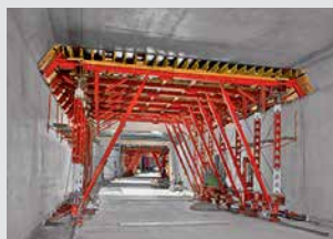
Coffrages de tunnels
