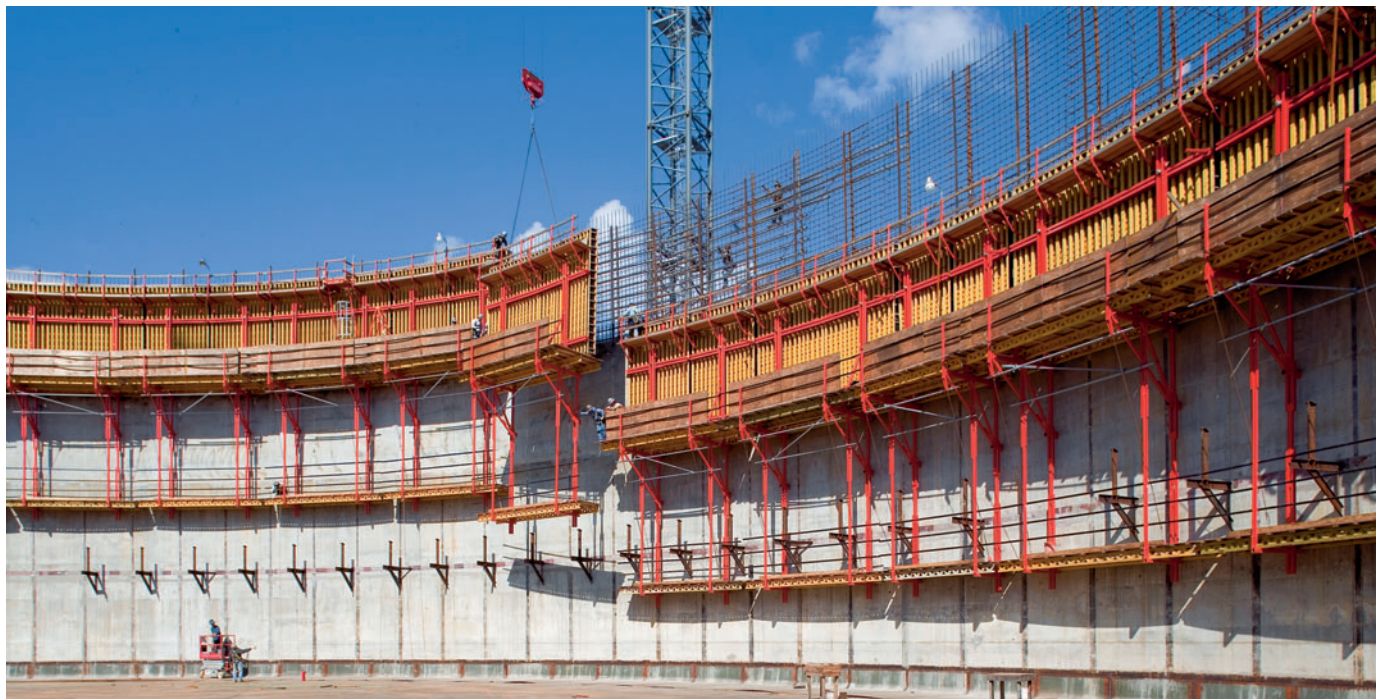
Réservoirs de gaz liquide Voiles circulaires Ø 77,50 m avec CB 240 et VARIO GT 24.
