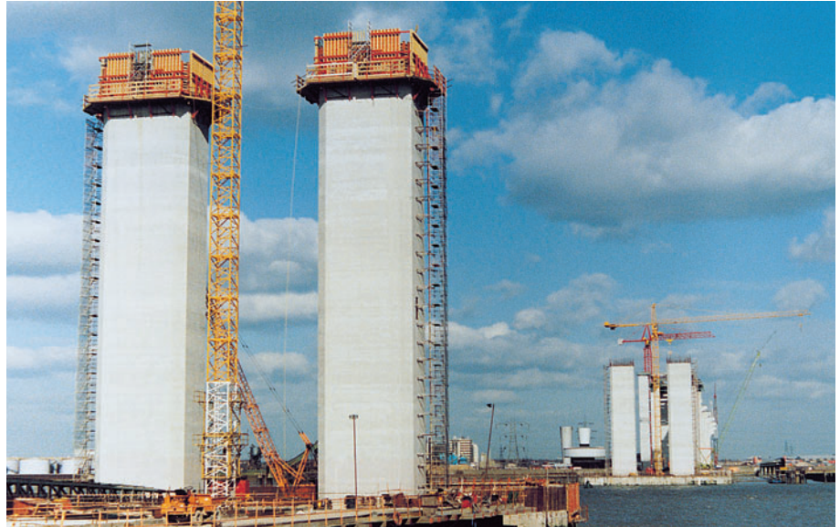
CB 240 avec coffrage de voiles VARIO GT 24 lors de la construction de piles de pont.
