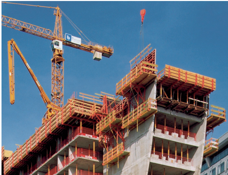
Construction d'hotels Consoles CB 240 complètes avec passerelle suspendue et TRIO.
