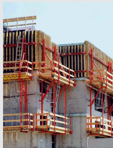
Sécurité Echelle d'accès PERI pour un accès sûr à la passerelle suspendue.
