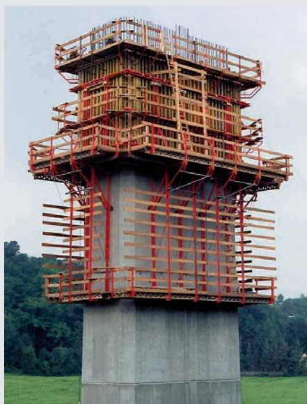
Pile de pont Béton architectural avec CB 240 et VARIO GT 24.
