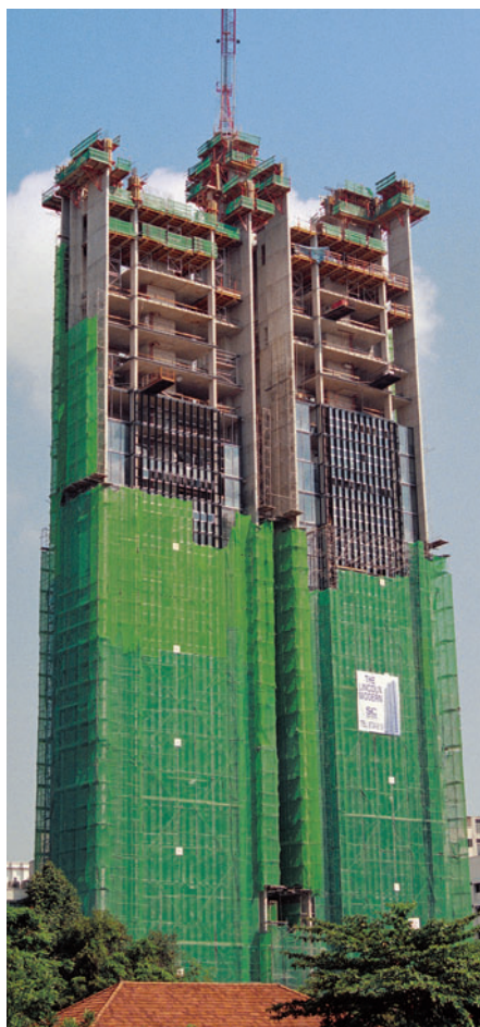
Immeuble d'habitation de 30 étages Consoles CB 240 et CB 160 avec VARIO GT 24.
