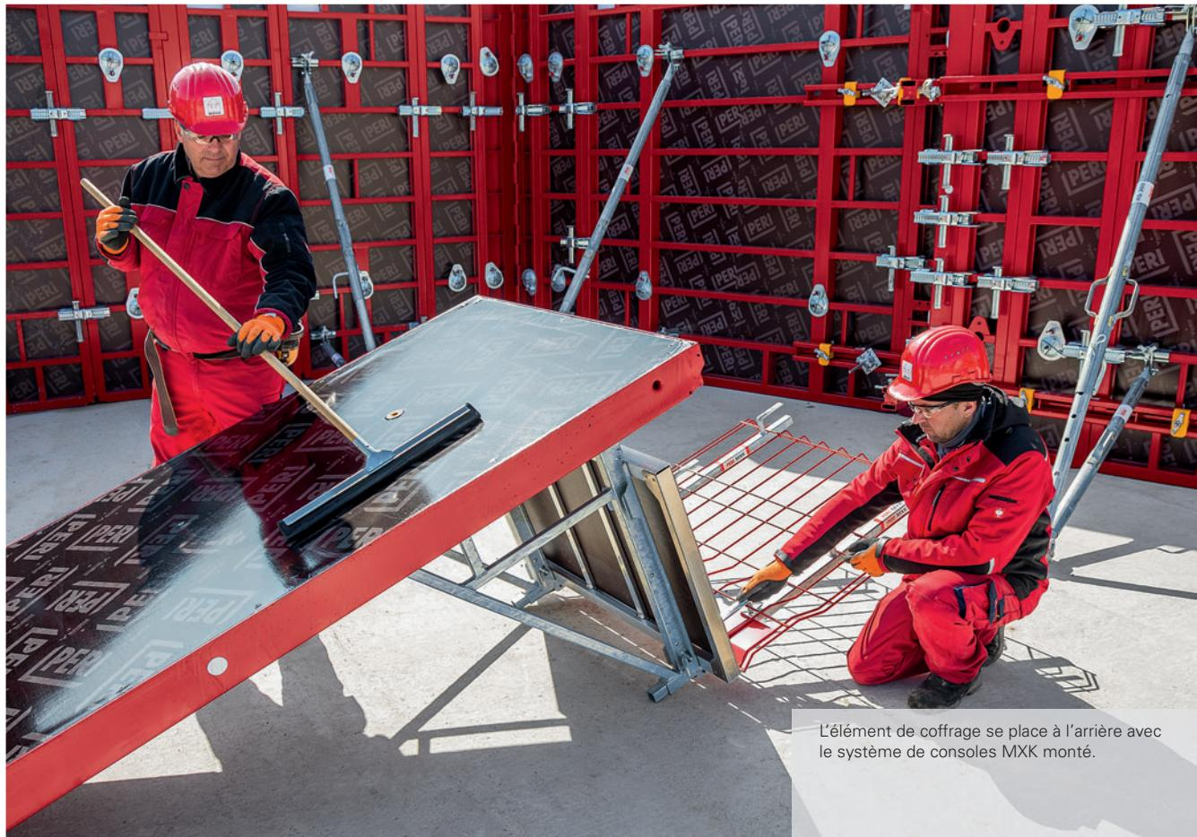
L'élément de coffrage se place à l'arrière avec le système de consoles MXK monté.
