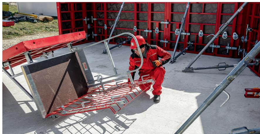
Consoles, platelage et montants de garde-corps sont mis en place sur le panneau, face au sol. L'ensemble est alors posé sur les consoles afin de mettre en oeuvre les garde-corps. On garantit ainsi que le garde-corps ne subira pas la contrainte de la chaîne de grue.
