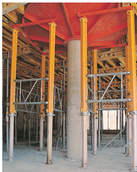
Tours MULTIPROP, hautes de 20 m, pour l'étaieement d'une dalle en encorbellement.
