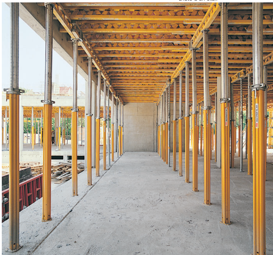
Etais MULTIPROP 350 et coffrage de dalles MULTIFLEX.
