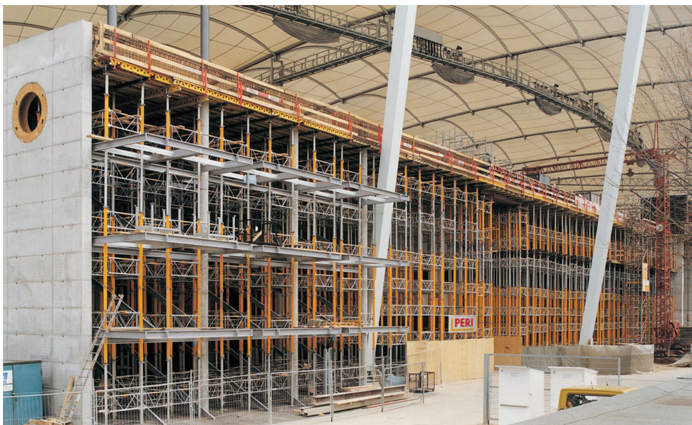
Reprise fiable de charges élevées: étaieement MULTIPROP, haut de 14,00 m, sur une surface de 3.500 m 2 .
