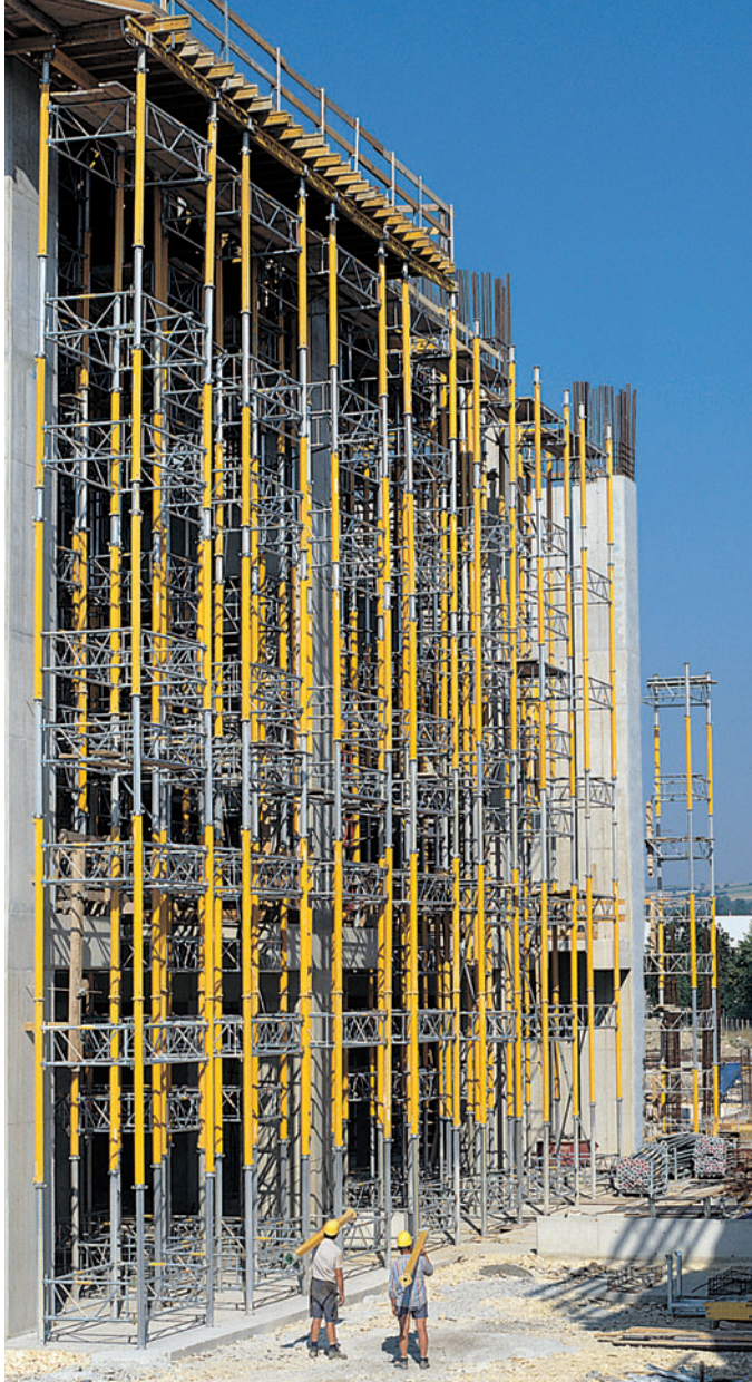
Tours MULTIPROP, hautes de 20 m, pour l'étaieement d'une dalle en encorbellement.
